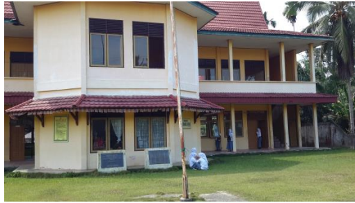
Tampak muka gedung SMK Terpadu Yayasan Ismailiyah, kondisi terkini (dokumen pribadi, 2016)
